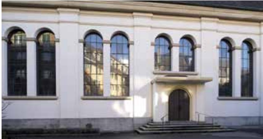
Die charakteristischen Merkmale der Seitenfassade sind im Bild gut zu erkennen. Die verhältnismässig niedrige Aussenwand wird im Wechsel von Wandpfeilern und Fenstern rhythmisiert, der untere Teil des hohen Mansarddachs schwingt elegant empor.
